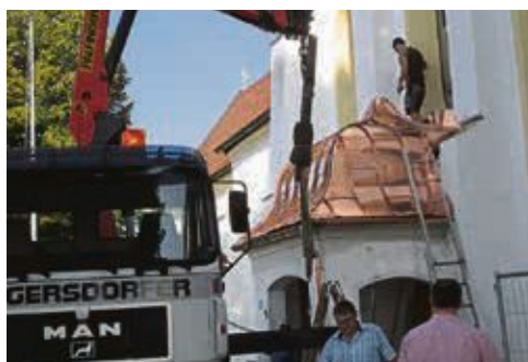
Die neue Kuppel wird installiert
