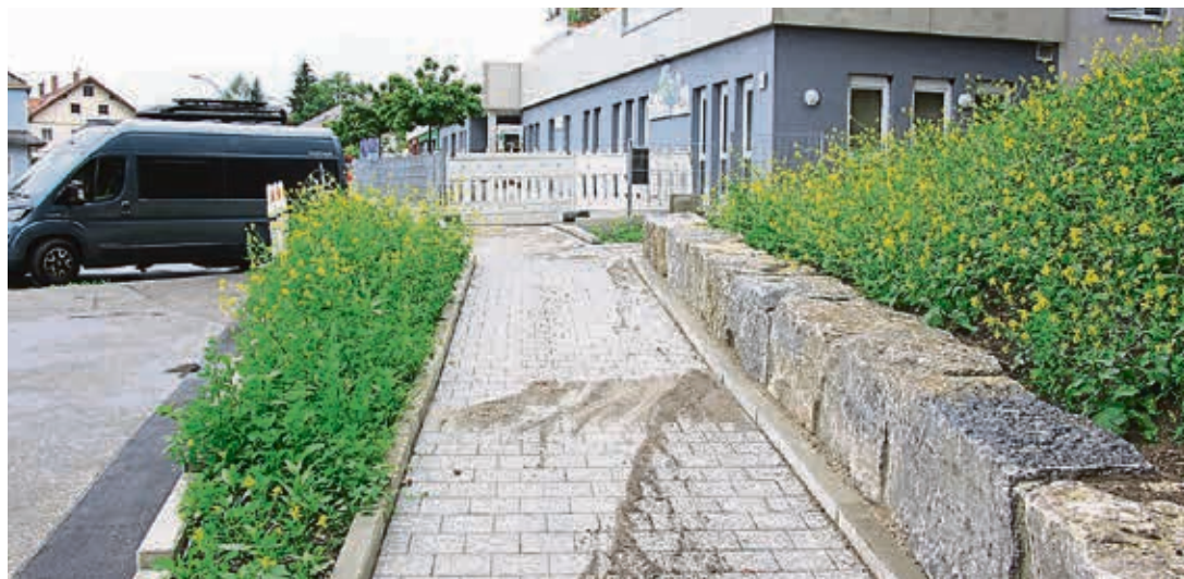
Derzeit entsteht am Schächen ein behindertengerechter Zugang. Die schiefe Ebene ermöglicht dann auch von der östlichen Seite her den Vorplatz mit Rollatoren, Rollstühlen und Kinderwagen zu erreichen.
