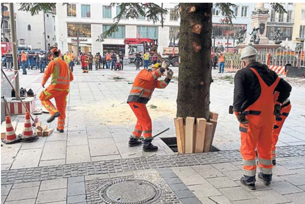
Der Stamm wird in der Halterung verkeilt, der Baum muss auch allen Stürmen standhalten.
