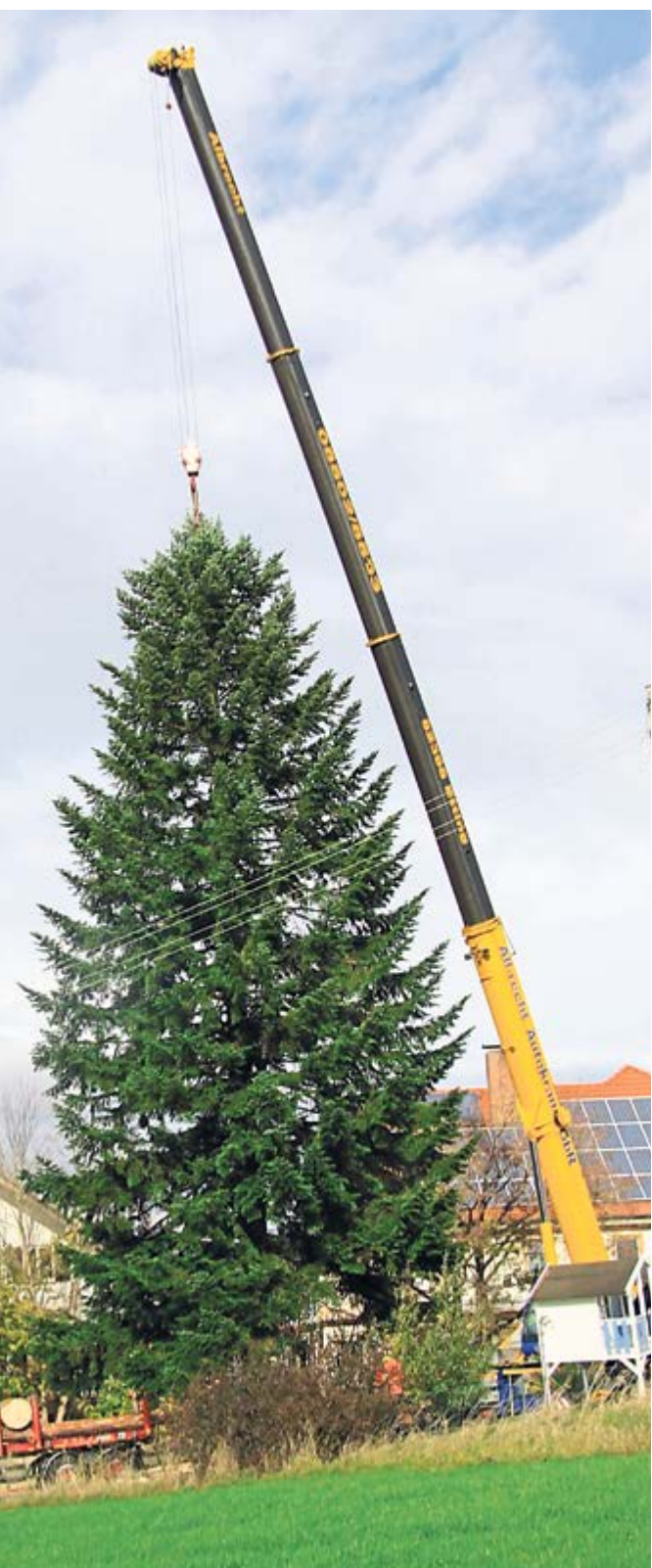
Hier steht noch der Baum, gut zu sehen die Stromleitungen, welche genau an ihm vorbeilaufen. Die vorsichtige Fällung erfolgte am Montag den 2.11.2022
